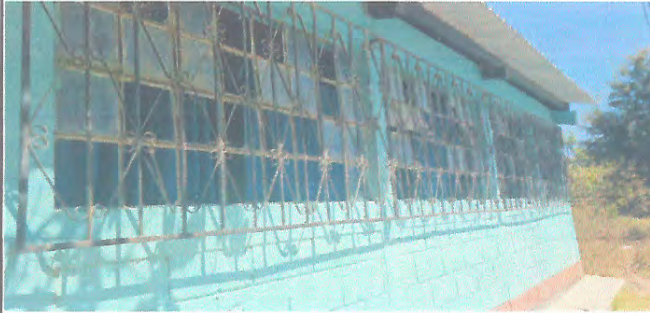
Foto 1: sustitución de vidrios, pintura de ventanillas, repello de pared pintura y sustitucion de torta de acera
